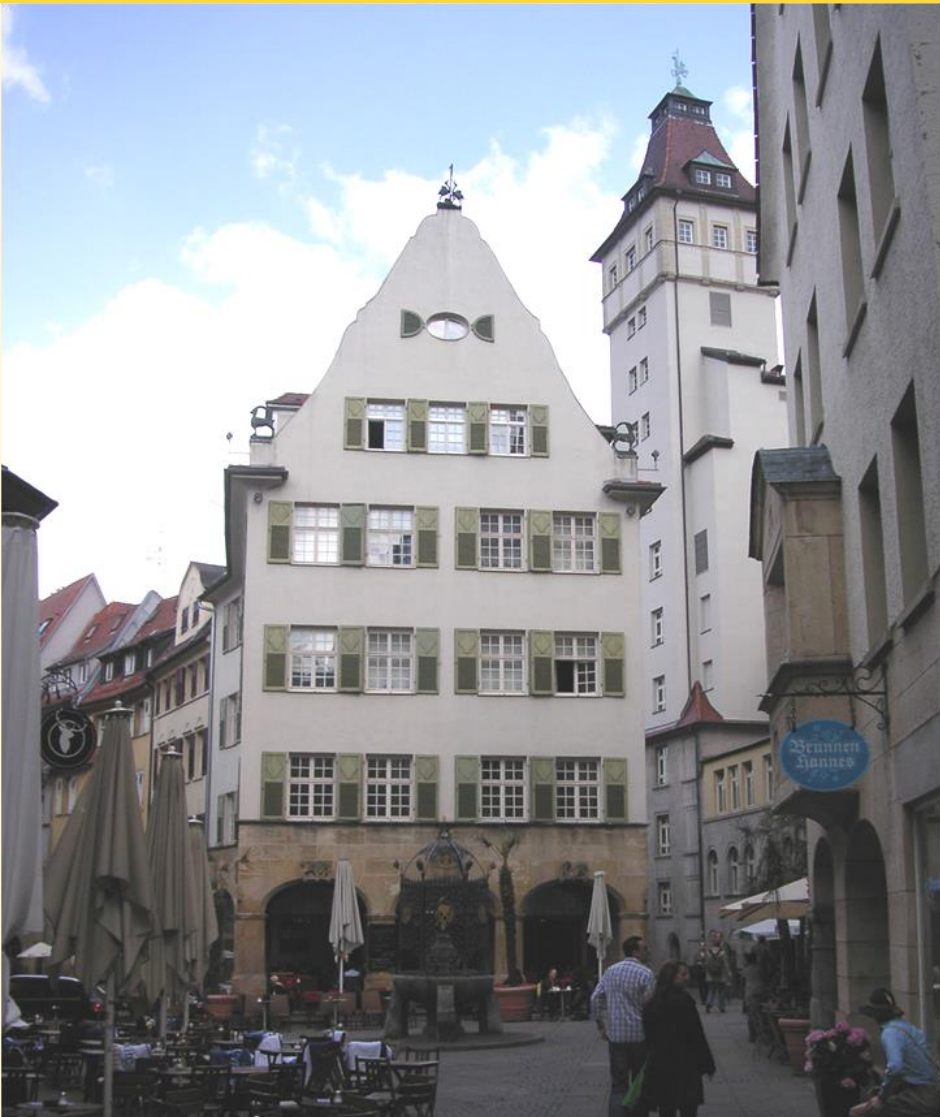
Priv. Modernisierung Beispiel Geißstraße 7
