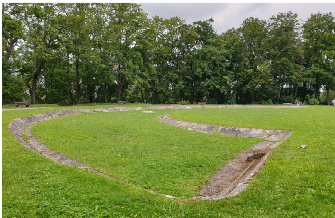
Blick über den ehemaligen Sichelsee und dessen historische Beckeneinfassung aus Stampfbeton, Bestand, Bild: LHS Amt 67
