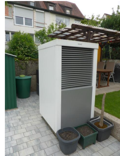
Quelle: Energieberatungszentrum Stuttgart
