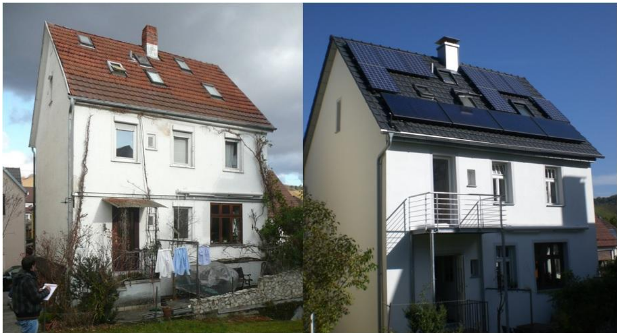
Vorher-Nachher-Vergleich einer durch das EBZ betreuten Sanierung (Quelle: EBZ)
