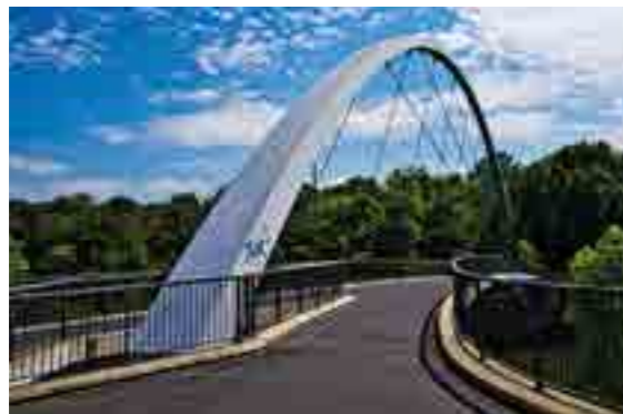
Brücken als Imagerträger in der Stadt der Brückenbauer, Vier-Burgen-Steg in Stuttgart, Foto MLP, Bild-Nr.: 57
