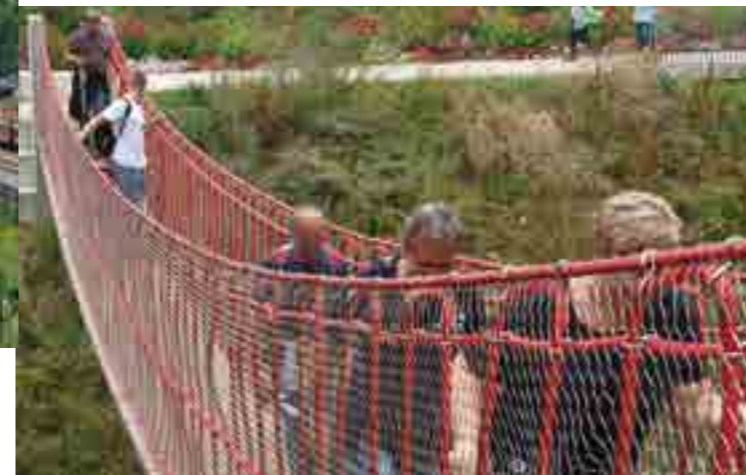
Wackelnde Brücken verbinden und machen nicht nur Kindern Freude, Beispiel Hängebrücke Josefsbach in Schwäbisch Gmünd, Foto Katrin Korth, Bild-Nr.: 54
