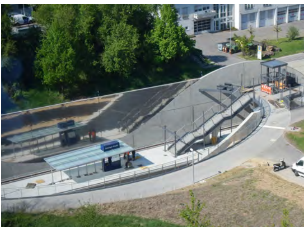
Abb. 2: Stadtbahnhaltestelle Bottroper Straße
