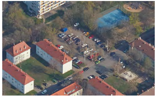
Abb. 39: Parkplatz Dessauer Straße
