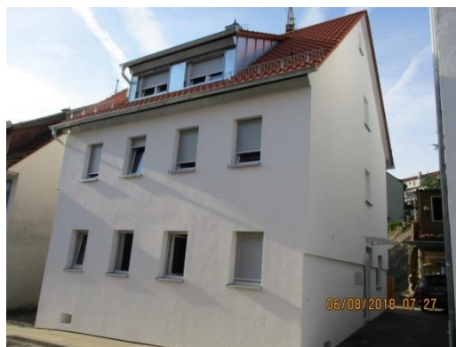
Abb. 9: Bsp. aus der Alten Stuttgarter Straße - nachher
