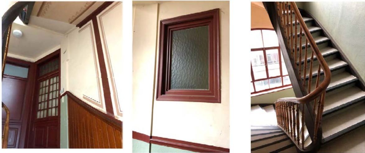
Abb. 4: Treppenaus I Hauptstätter Straße/Fangelsbachstraße
