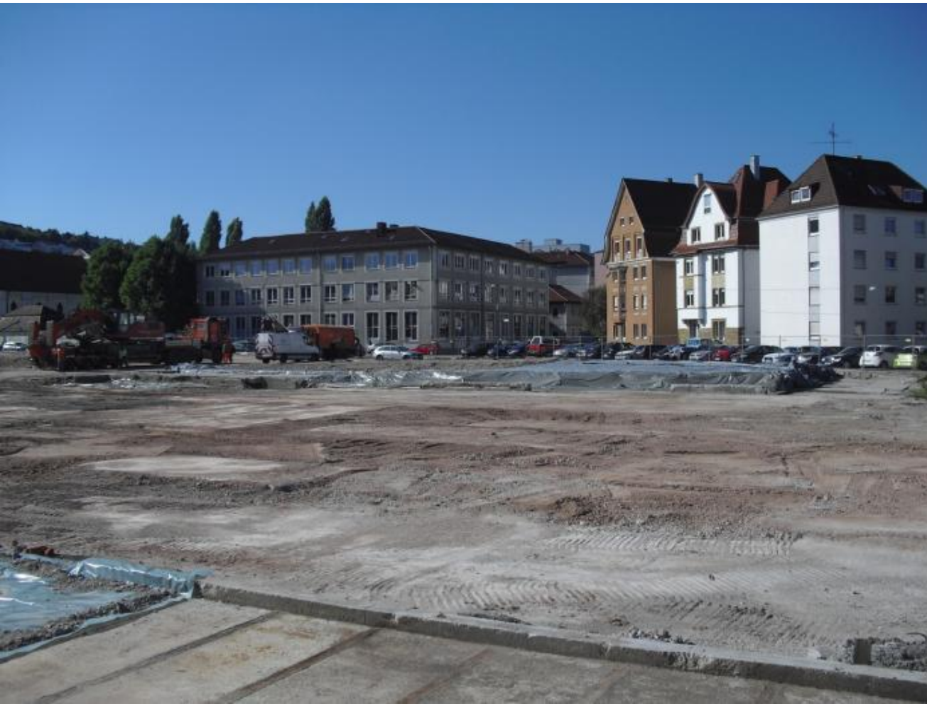
Abbrüche - Beispiel Schoch-Areal
