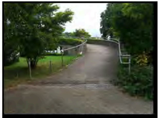
Abbildung 4: Rad-Fußweg-Brücke (Steg Süd)
