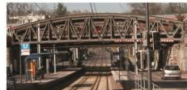
9. Stahlfachwerkbrücken über die Nordbahnhofstraße
