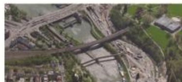
4. Eisenbahnbrücke über den Neckar
