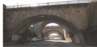
8. Eisenbahnbrücken über die Goppeltstraße
