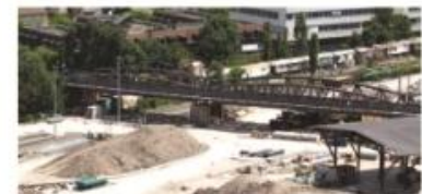
11. Fachwerkbrücke über den Nordbahnhof
