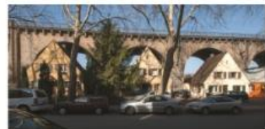
10. Gäubahnüberführung/ Gäubahnrampe (nördliches Überwerfungsbauwerk)
