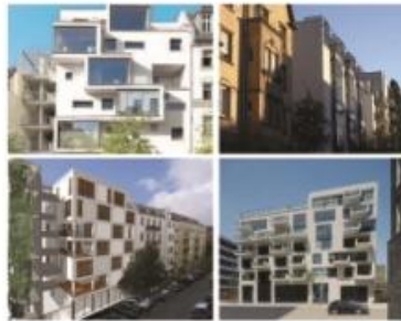
Aggregierte und integrierte Fassade
