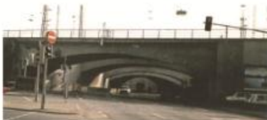
1. Stahlbetonbrücken über die Wolframstraße
